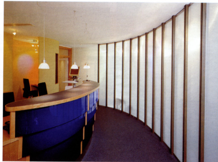
In einer Hamburger Arztpraxis verbreiten TWD-Elemente weiches Licht am fensterfernen Empfangstresen.
