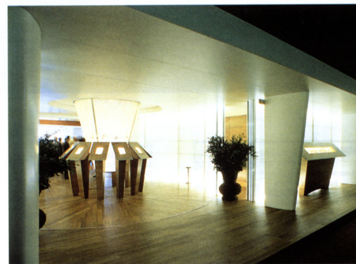
Für diesen Messestand wurde eine zweischalige, gebogene TWD-Wand mit dazwischen liegender Beleuchtung konstruiert.
