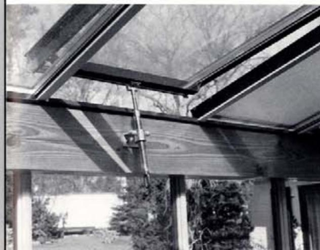
223 Über Lüftungsschlitze der Holzschiebefenster (unten im Foto) kann warme Luft nach innen in den Arbeitsraum geführt oder über die Dauerentlüftungsklappe (oben) nach außen abgeleitet werden.
